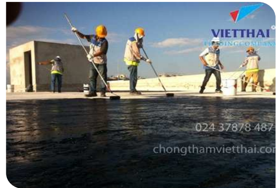
Thi công lăn lớp lót
