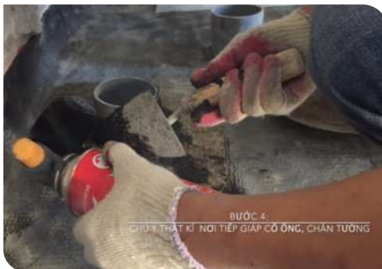
Xử lý cổ ống thoát nước
