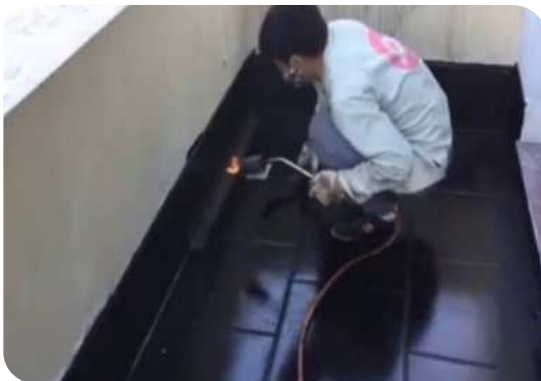
Xử lý góc chân tường
