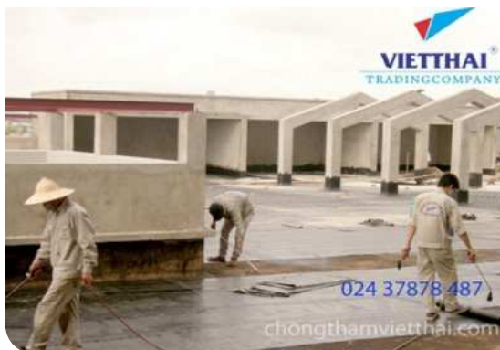
Thi công màng khô nóng
