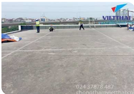
Chuẩn bị bề mặt
