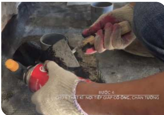
Xử lý cổ ống thoát nước
