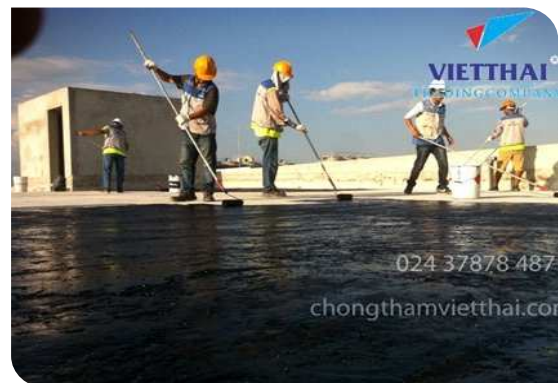
Thi công lăn lớp lót
