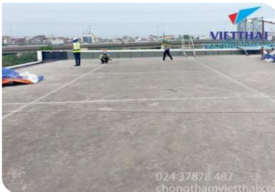
Chuẩn bị bề mặt
