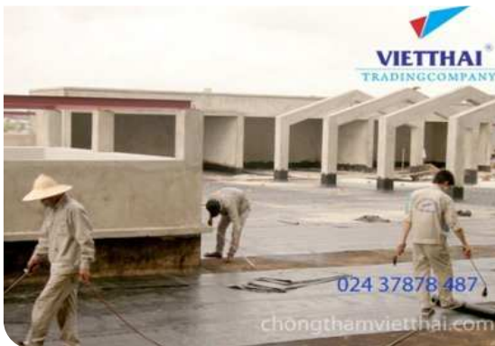
Thi công màng khô nóng
