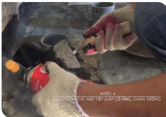
Xử lý cổ ống thoát nước
