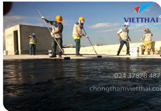
Thi công lăn lớp lót
