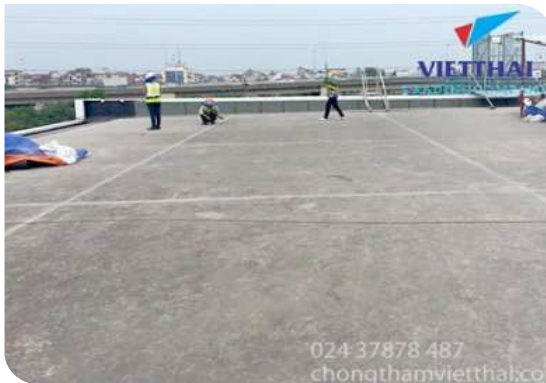
Chuẩn bị bề mặt
