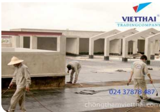
Thi công màng khô nóng
