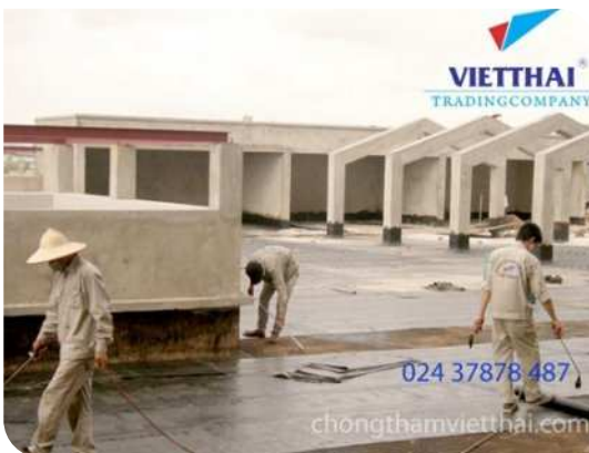
Thi công màng khô nóng
