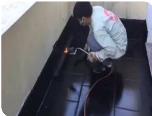
Xử lý góc chân tường
