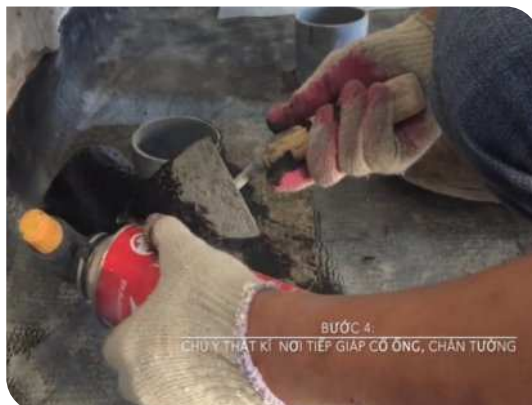
Xử lý cổ ống thoát nước
