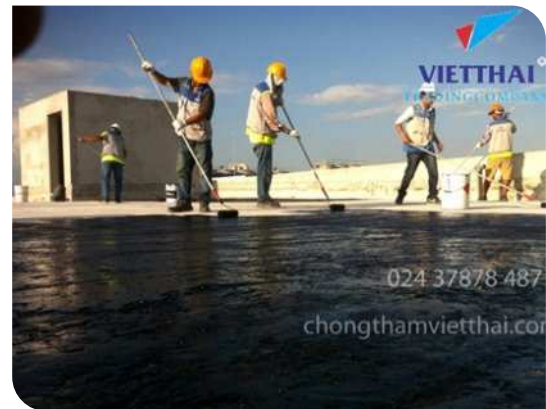
Thi công lăn lớp lót
