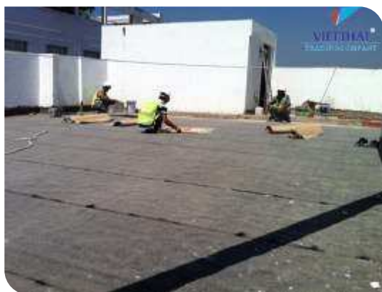
Thi công màng tự dính
