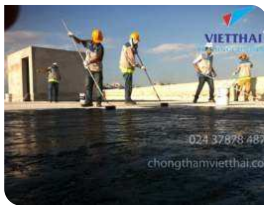
Thi công lăn lớp lót
