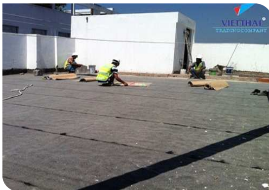
Thi công màng tự dính
