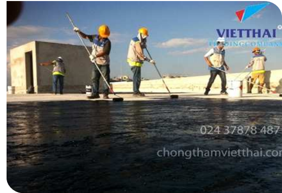
Thi công lăn lớp lót
