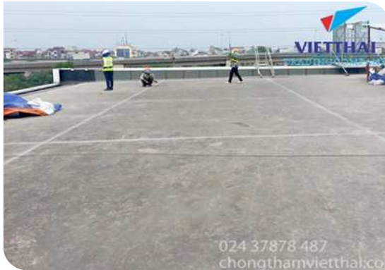
Chuẩn bị bề mặt
