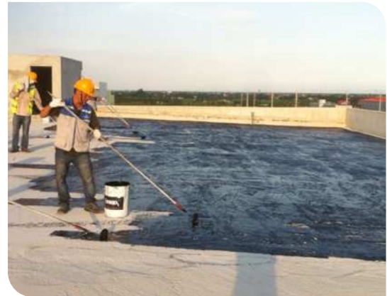
Thi công lăn lớp lót
