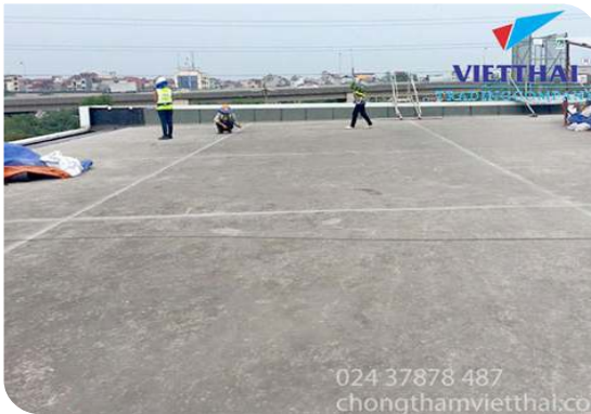
Chuẩn bị bề mặt
