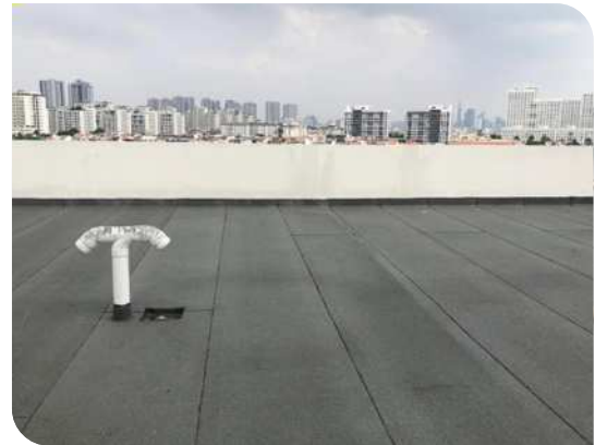
Bề mặt hoàn thiện
