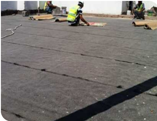
Thi công màng tự dính
