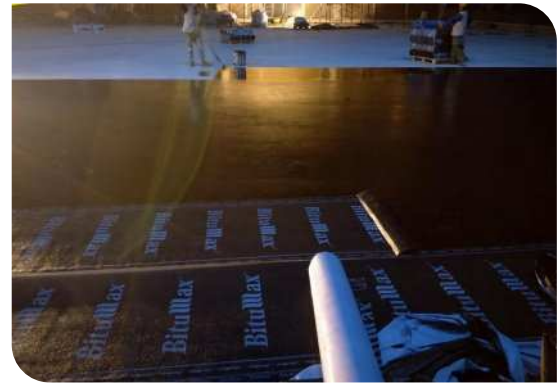
Thi công lăn lớp lót
