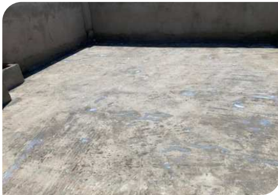
Chuẩn bị bề mặt
