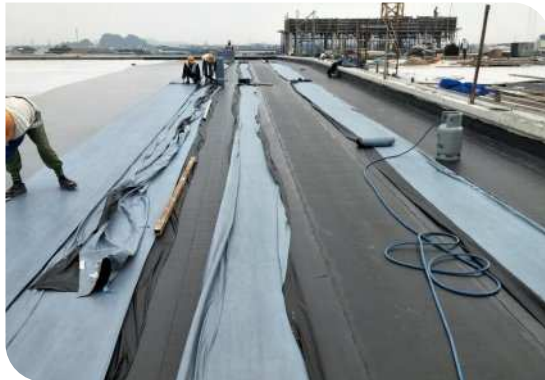
Thi công màng khô nóng
