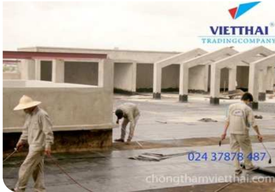
Thi công màng khô nóng
