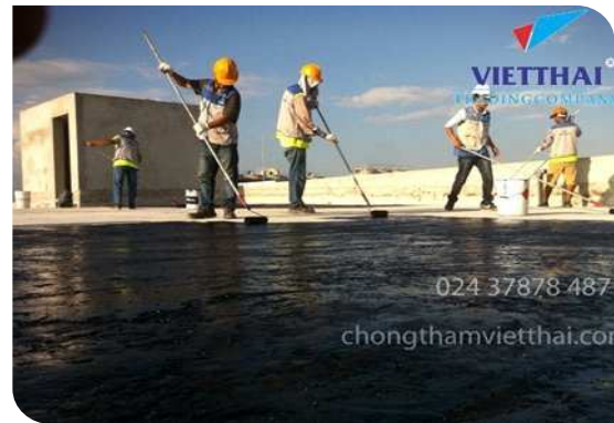
Thi công lăn lớp lót
