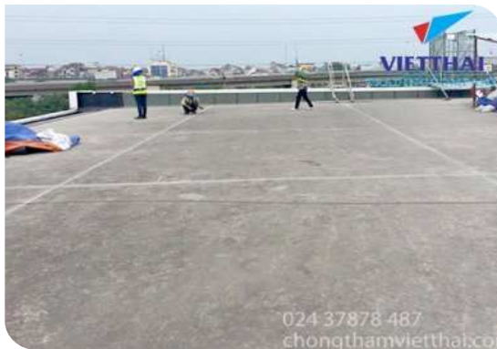
Chuẩn bị bề mặt
