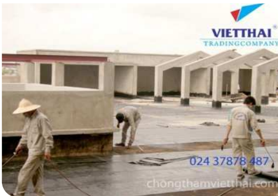
Thi công màng khô nóng
