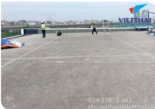
Chuẩn bị bề mặt
