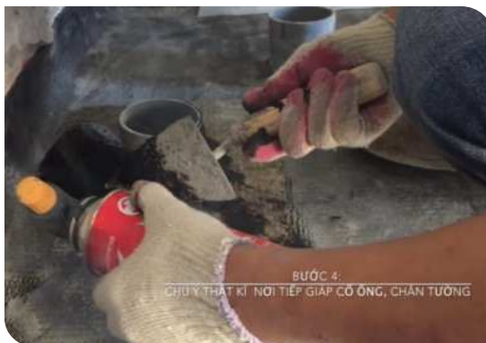
Xử lý cổ ống thoát nước
