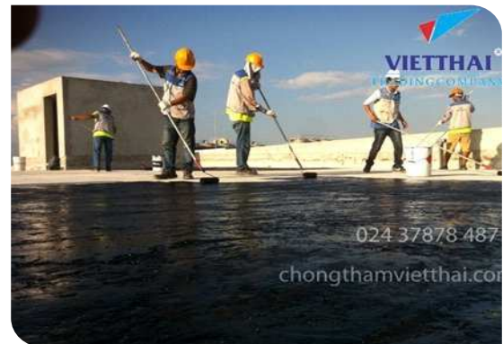
Thi công lăn lớp lót
