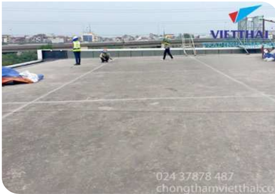
Chuẩn bị bề mặt
