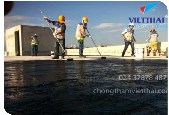
Thi công lăn lớp lót
