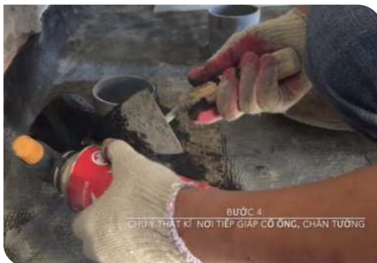
Xử lý cổ ống thoát nước
