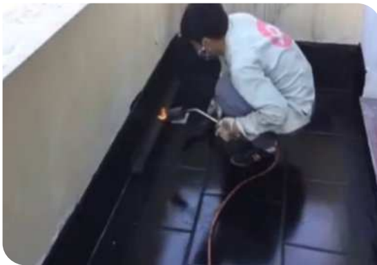
Xử lý góc chân tường
