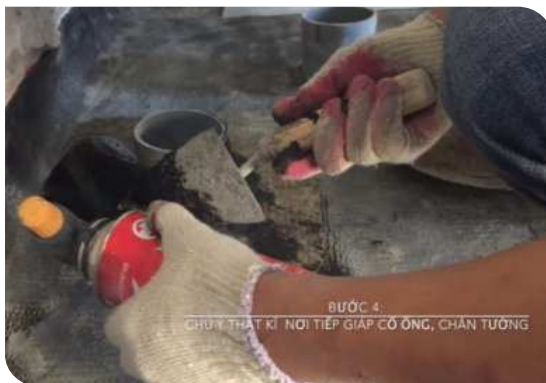
Xử lý cổ ống thoát nước
