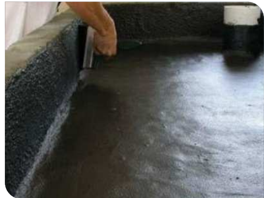
Thi công lăn lớp lót
