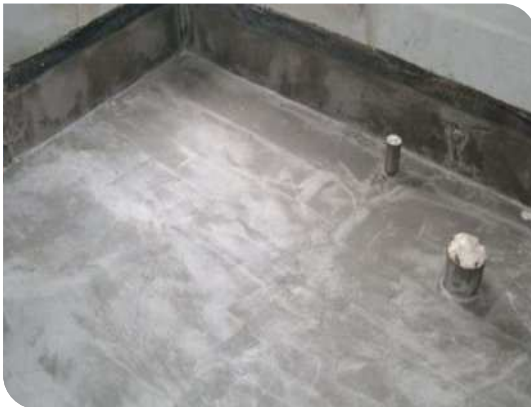
Chuẩn bị bề mặt
