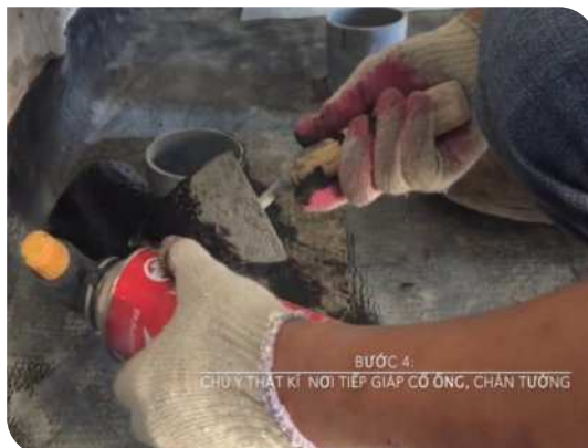
Xử lý cổ ống thoát nước
