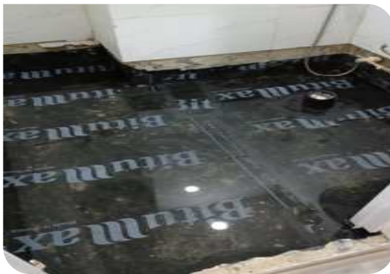
Thi công màng tự dính
