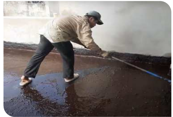
Thi công lăn lớp lót
