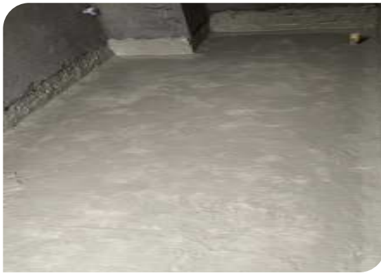
Chuẩn bị bề mặt
