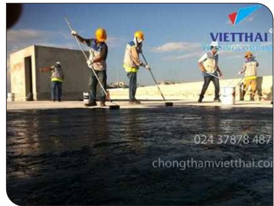
Thi công lăn lớp lót
