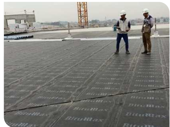
Bề mặt hoàn thiện
