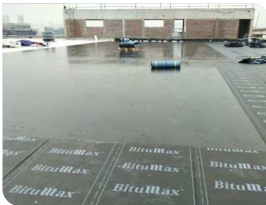
Thi công màng tự dính
