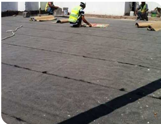
Thi công màng tự dính
