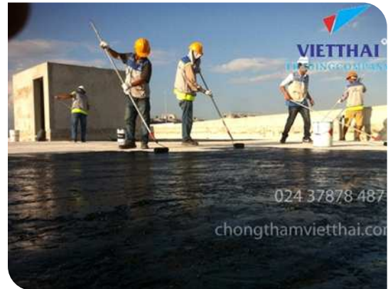
Thi công lăn lớp lót
