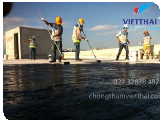
Thi công lăn lớp lót
