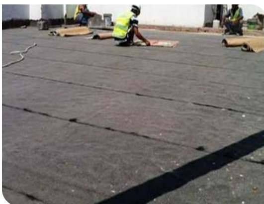
Thi công màng tự dính
