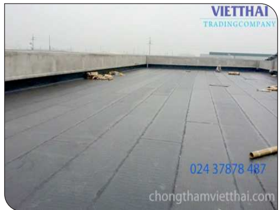
Bề mặt hoàn thiện
