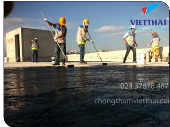
Thi công lăn lớp lót
