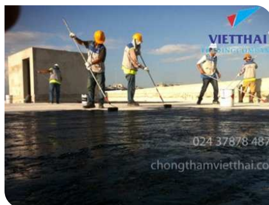
Thi công lăn lớp lót
