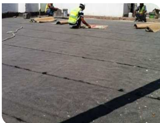
Thi công màng tự dính
