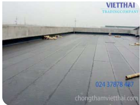
Bề mặt hoàn thiện
