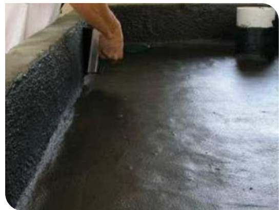
Thi công lăn lớp lót
