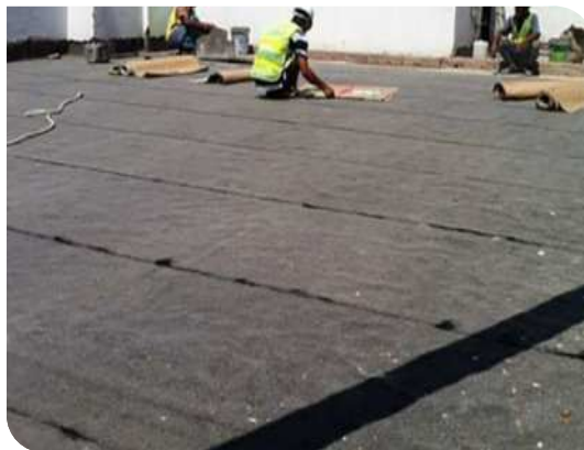
Thi công màng tự dính
