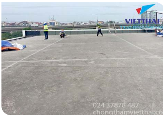
Chuẩn bị bề mặt
