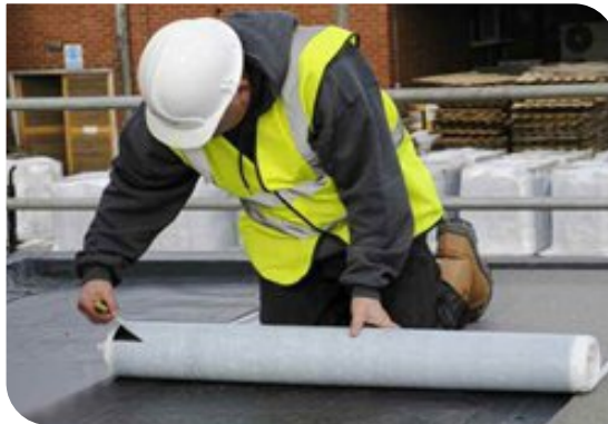
Thi công màng tự dính
