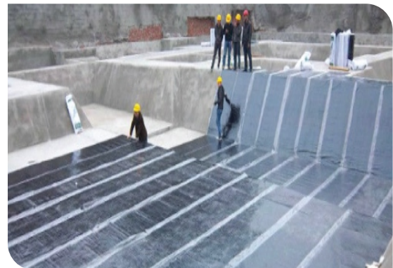
Bề mặt hoàn thiện
