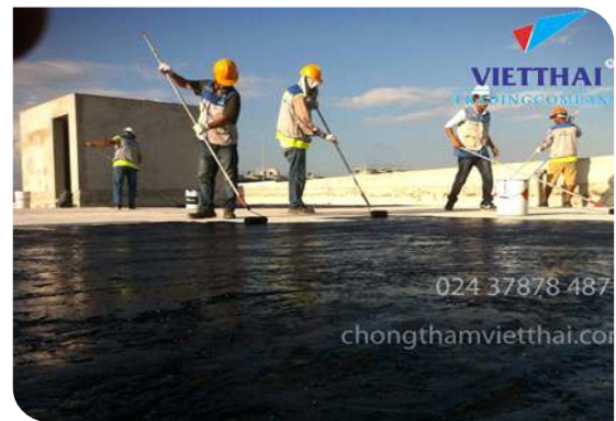
Thi công lăn lớp lót
