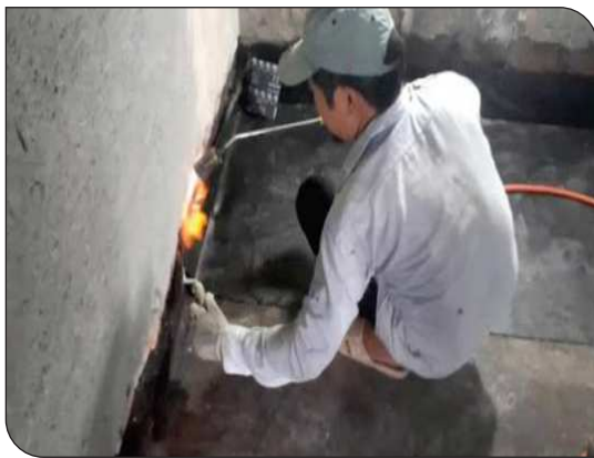
Thi công màng khò nóng
