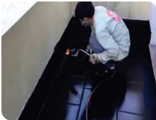
Xử lý góc chân tường
