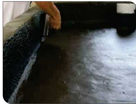
Thi công lăn lớp lót
