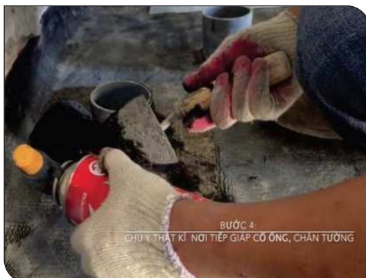
Xử lý cổ ống thoát nước
