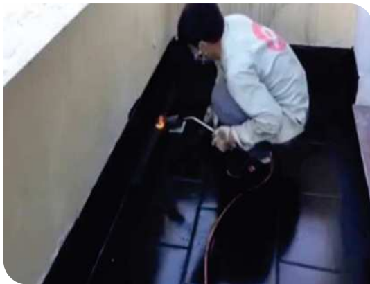
Xử lý góc chân tường
