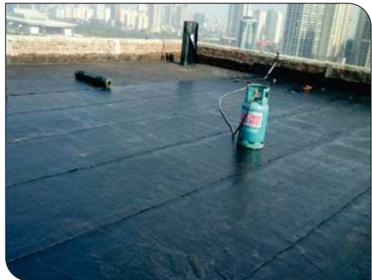
Bề mặt hoàn thiện
