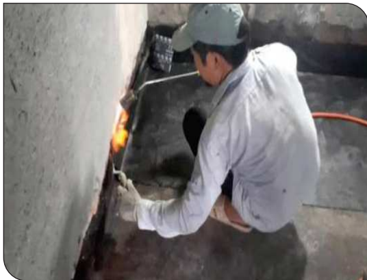
Thi công màng khô nóng
