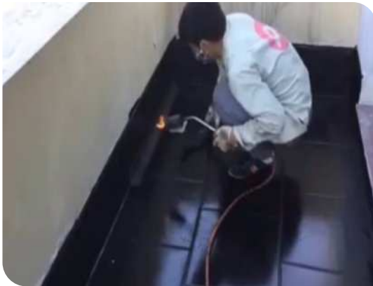
Xử lý góc chân tường
