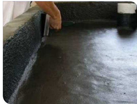
Thi công lăn lớp lót
