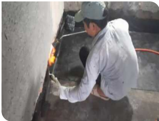
Thi công màng khô nóng
