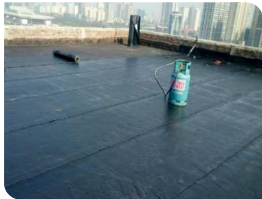
Bề mặt hoàn thiện
