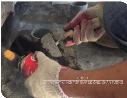
Xử lý cổ ống thoát nước
