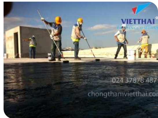
Thi công lăn lớp lót
