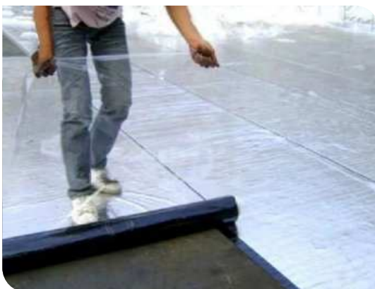
Thi công màng tự dính mặt nhôm
