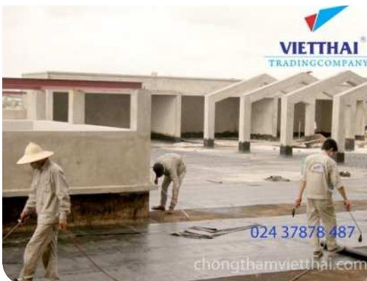
Thi công màng khô nóng
