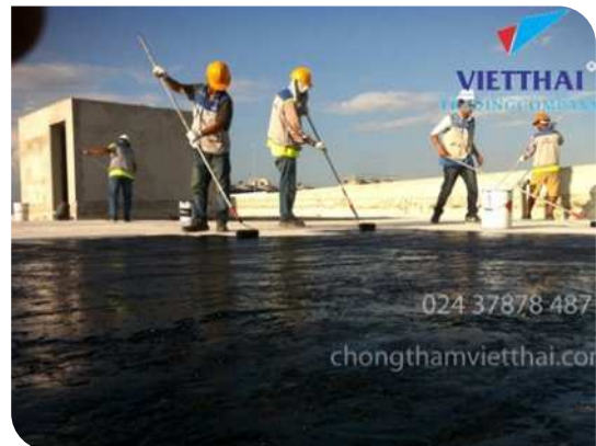
Thi công lăn lớp lót
