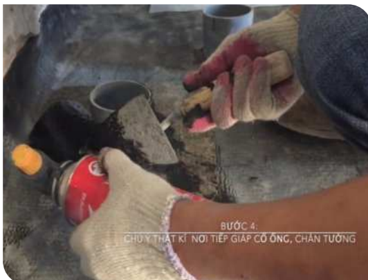
Xử lý cổ ống thoát nước
