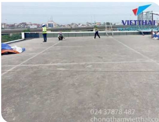
Chuẩn bị bề mặt
