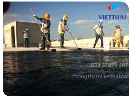
Thi công lăn lớp lót
