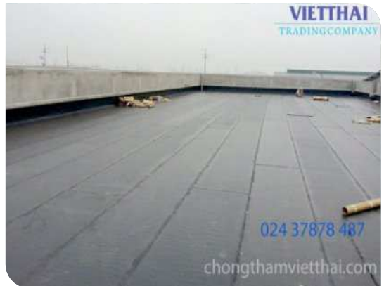
Bề mặt hoàn thiện
