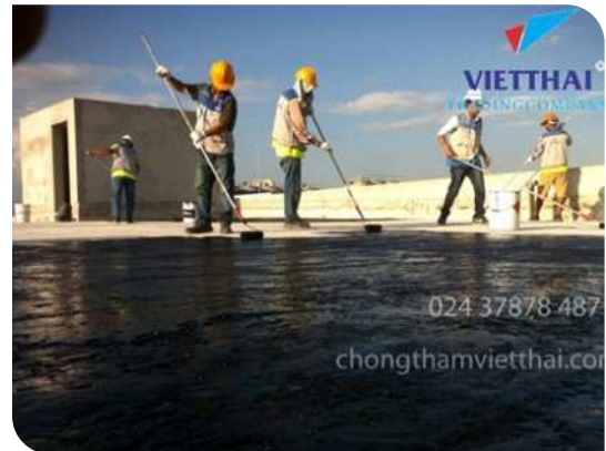
Thi công lăn lớp lót
