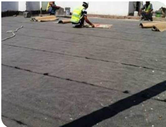
Thi công màng tự dính
