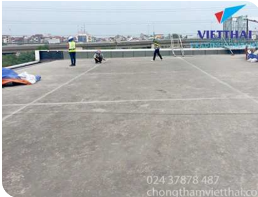
Chuẩn bị bề mặt
