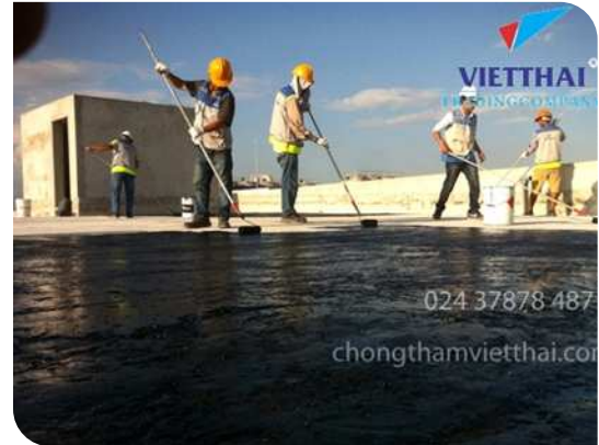
Thi công lăn lớp lót
