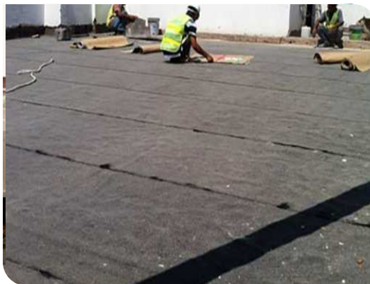
Thi công màng tự dính
