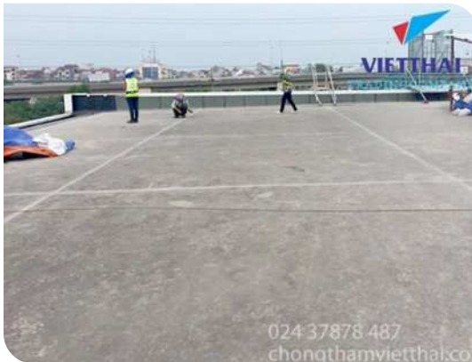
Chuẩn bị bề mặt
