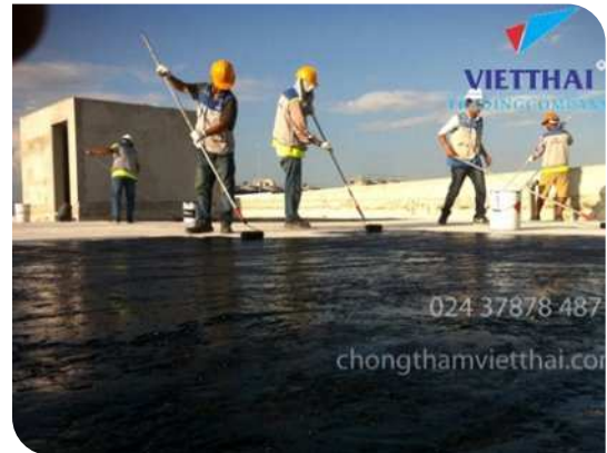
Thi công lăn lớp lót
