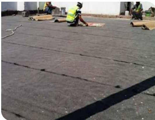
Thi công màng tự dính
