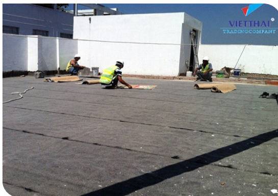
Thi công màng tự dính
