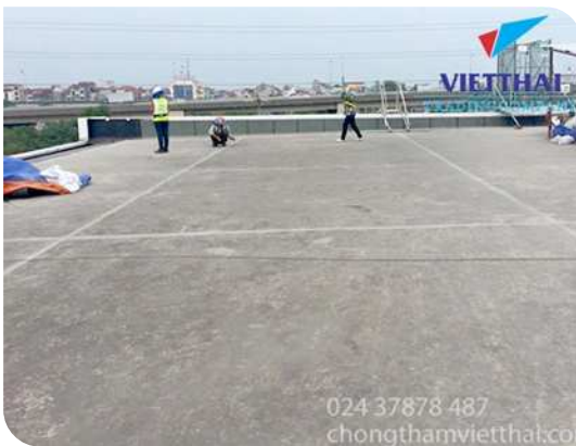
Chuẩn bị bề mặt
