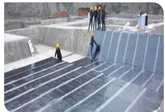
Bề mặt hoàn thiện
