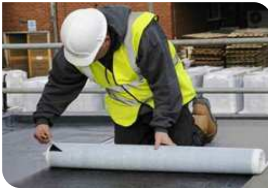
Thi công màng tự dính
