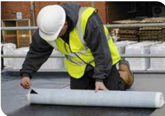
Thi công màng tự dính
