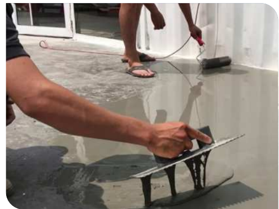
Thi công cán hồ dầu
