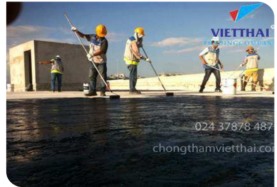
Thi công lăn lớp lót
