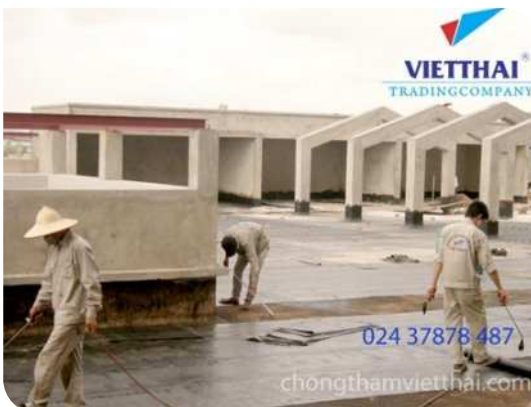
Thi công màng khô nóng
