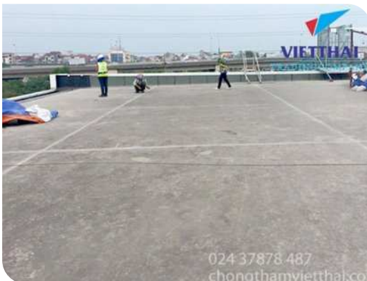
Chuẩn bị bề mặt
