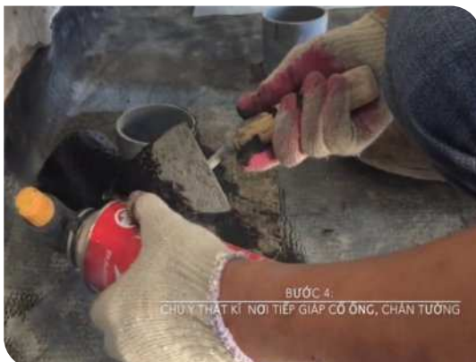
Xử lý cổ ống thoát nước
