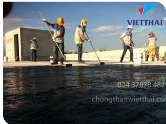
Thi công lăn lớp lót
