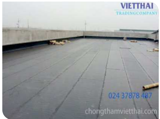
Bề mặt hoàn thiện
