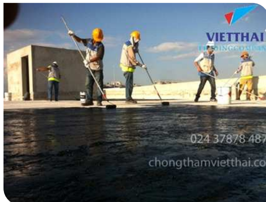
Thi công lăn lớp lót
