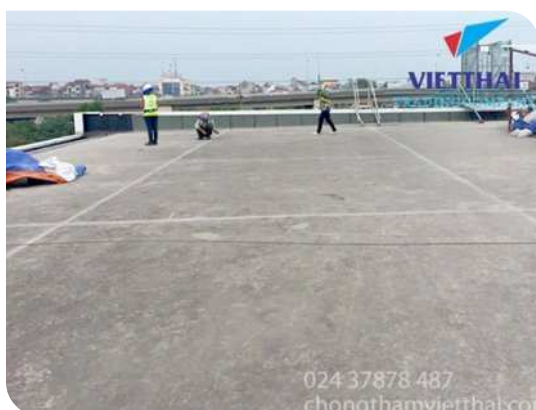
Chuẩn bị bề mặt
