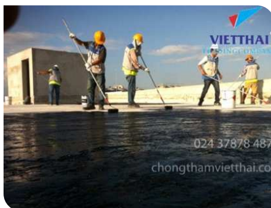
Thi công lăn lớp lót
