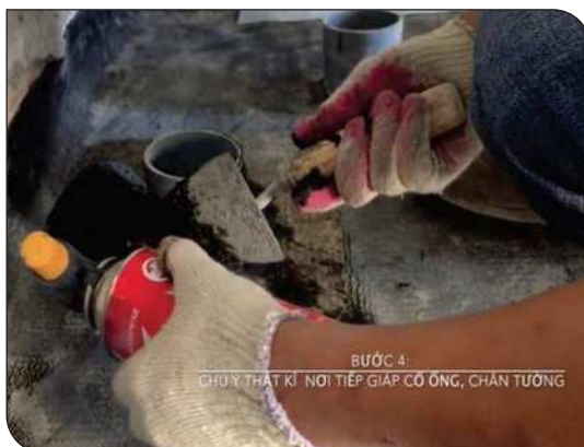
Xử lý cổ ống thoát nước
