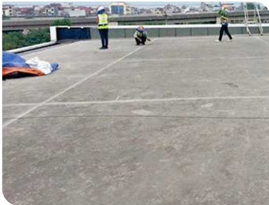
Chuẩn bị bề mặt
