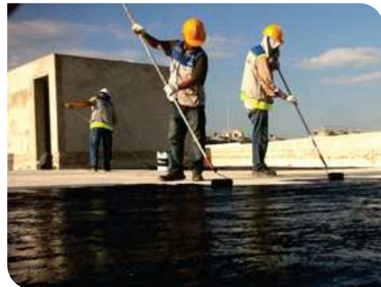
Thi công lăn lớp lót
