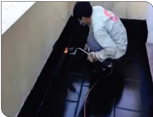
Xử lý góc chân tường
