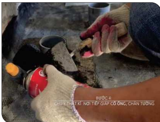
Xử lý cổ ống thoát nước
