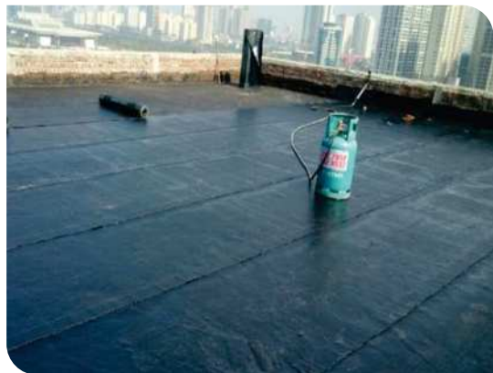
Bề mặt hoàn thiện
