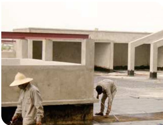
Thi công màng khò nóng
