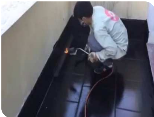
Xử lý góc chân tường
