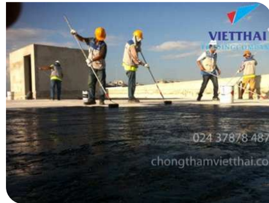
Thi công lăn lớp lót
