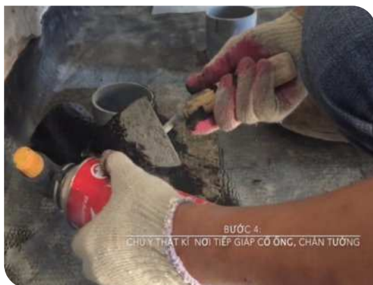
Xử lý cổ ống thoát nước
