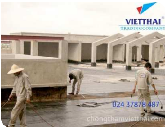
Thi công màng khô nóng
