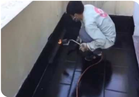
Xử lý góc chân tường
