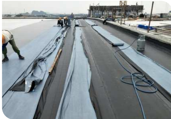
Thi công màng khô nóng
